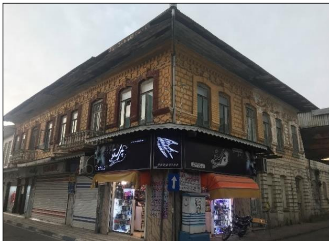
شکل ۲: نمای اصلی بنای عمارت قاسم اوف (خیابان سپه)
