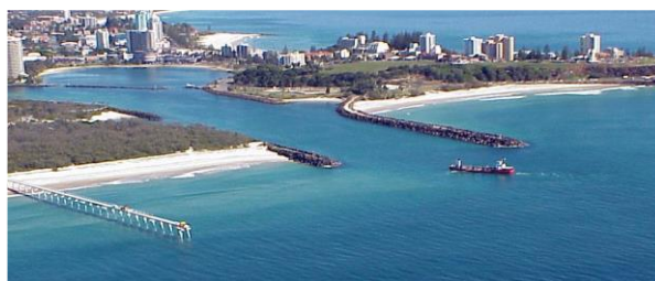
شکل ۱: سامانه کنارگذری با حالت عملیاتی مداخله‌ای واقع در دهانه رودخانه توید استرالیا [۱۶]
